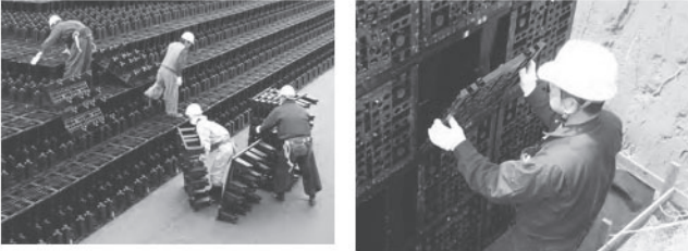
組立て作業の様子
