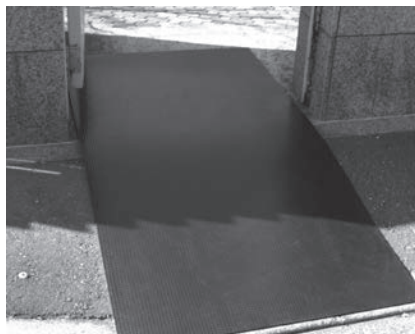
マンション工事通路養生
